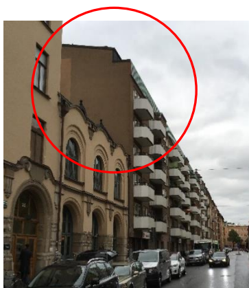
Brandgavel mot grannfastigheten Råttan 10 (Brandstationen).
