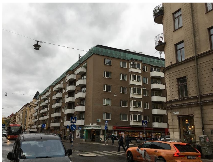
Vy från Krukmakargatan mot väst. Fastigheten löper över hörnet med långsidan mot Krukmakargatan och kortsidan mot Torkel Knutssonsgatan.
