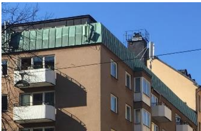
Kopparplåten löper runt hela byggnaden med avbrott för brandgaveln.
