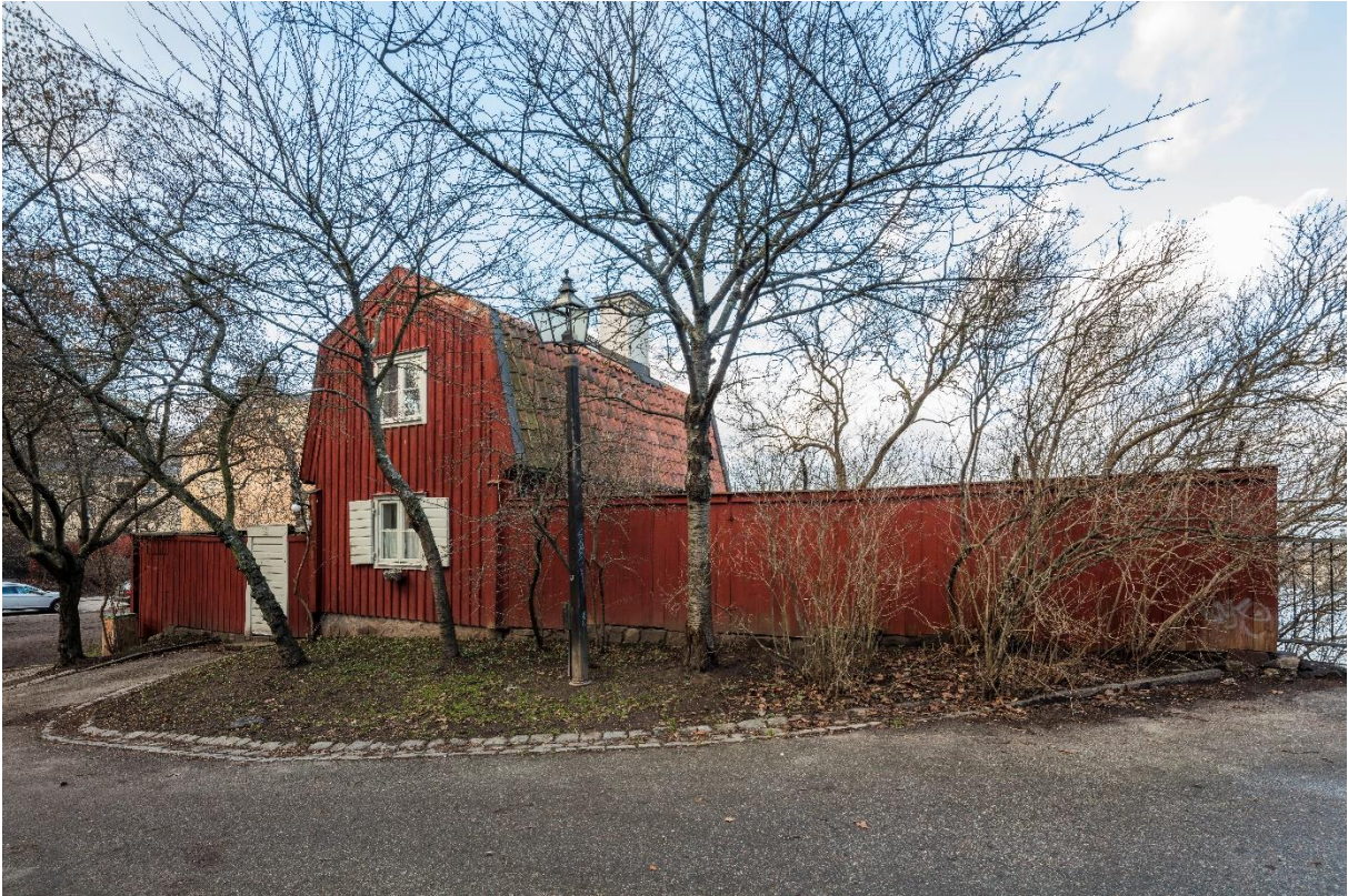
F d Högbergsgatan 4, nu Nytorngatan 7, i kv Terrassen, bild mot norr. I bild syns syrener och körsbärsträd. ME SSM_10037348.
