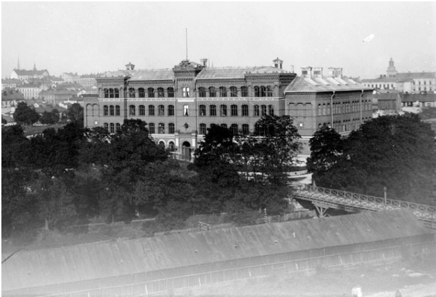
Det ursprungliga spårområdet nordost om Tantolunden utgjorde en barriär. Här kanaliserades parkentréen till en träbro i korsningen vid Ringvägen som skulle underlätta för eleverna på Maria Folkskola. Foto: Alrutz, A.O. Ca 1890-1899. Bild.nr. C3482, Stockholms stadsmuseum.
