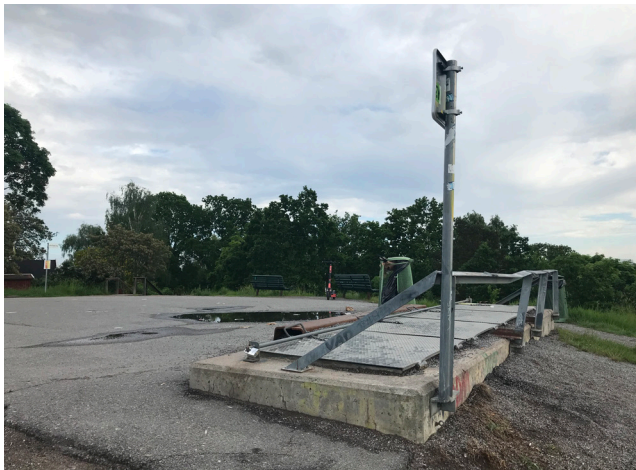
Lucka tillhörande sandsilons intag/kasun, vilken inte får blockeras.
