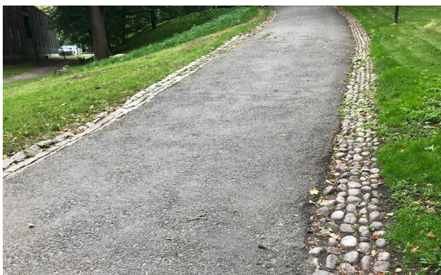
Bilden visar en äldre rännal med kullsten itill höger och en yngre rännal av gatsten till vänster.
