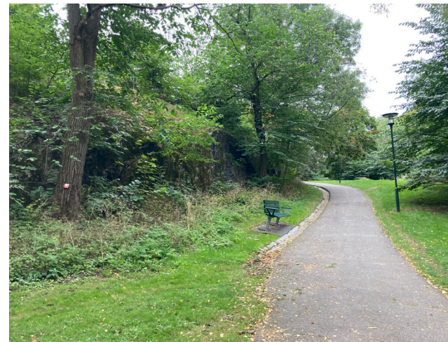
Bilden visar ett parti där rännalen slutar och gräset har etablerat sig på gångvägens ena sida.
