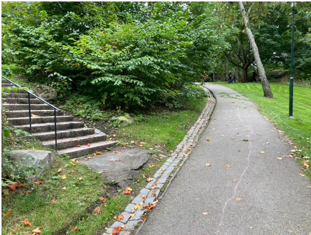
Bilden visar ett tråkigt exempel på hur anslutande trappa inte mynnar i gångvägen på ett genomtänkt sätt, utan upplevs som trasigt och slitet. Ojämnheten innebär dessutom en säkerhetsrisk.
