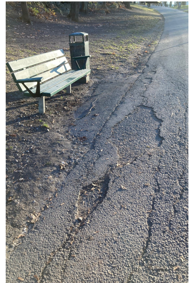
I motljus kan ojämnheter och hål i asfalten p.g.a. att tunga fordon har trafikerat ytan innebära en säkerhetsrisk, då fotgängarna riskerar att snubbla.
