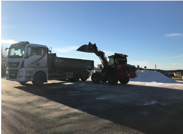
Pågående lastning av sand till silon på vändplanen. Transporter för Trafikkontorets vägsandning sker under stora delar av året, vilket begränsar användningen för andra aktiviteter på platsen.
