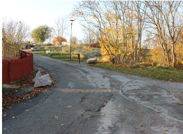
Tantolundsvägen spärras av med en vägbom, men som återkommande förstörs av olovlig trafik. Vägbanan är trasig med många hål i asfalten, p.g.a. de tunga fordon som åker upp till sandsilon.
