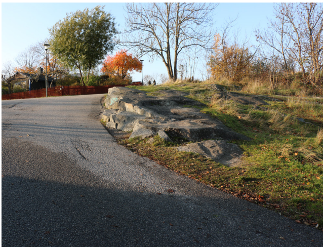
Tantolundsvägen saknar rännalar på sträckan upp mot toppen. Här behöver dagvatten tas om hand. Anläggande av rännalar kan vara en del av lösningen.
