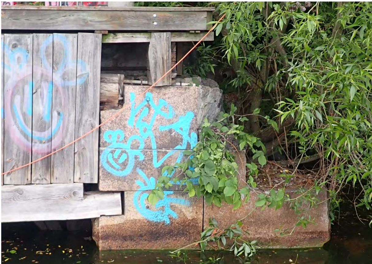
Foto 4 – visar överbyggnad på stenkista 2.
