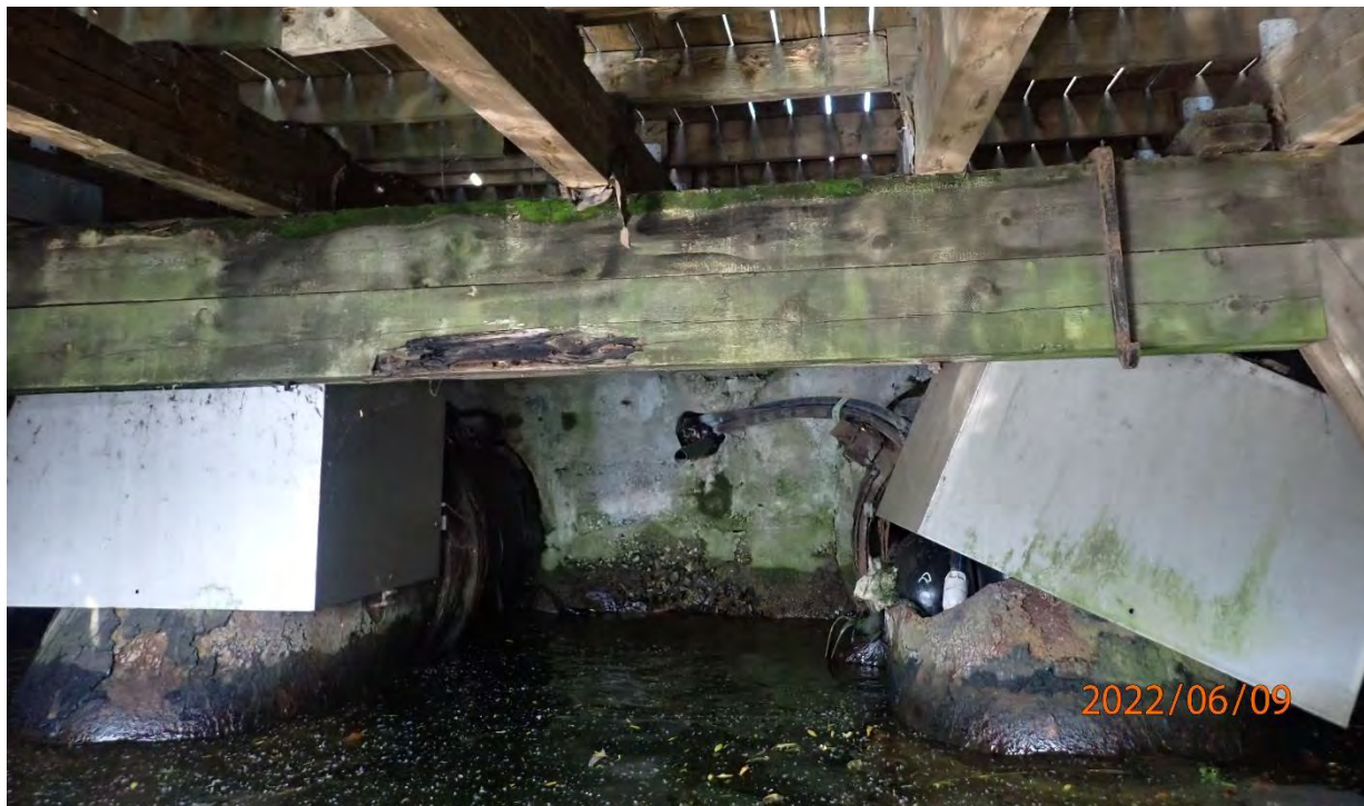
Foto 7 – visar bryggans bakre vägg/kajmur där även två större rörtrummor kommer ut.
