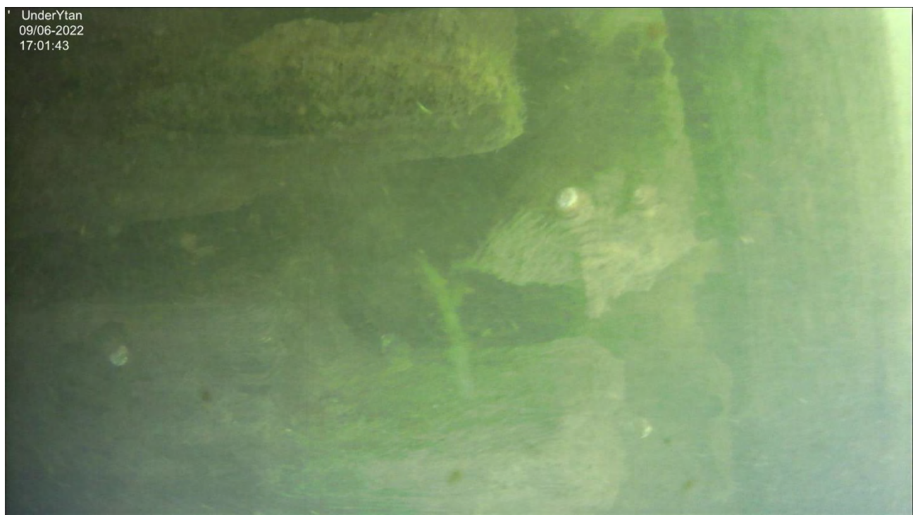
Foto 6 – visar upplösta knutbrädor där stockarna i kistan hålls på plats av slagna träpålar på kistans utsida.
