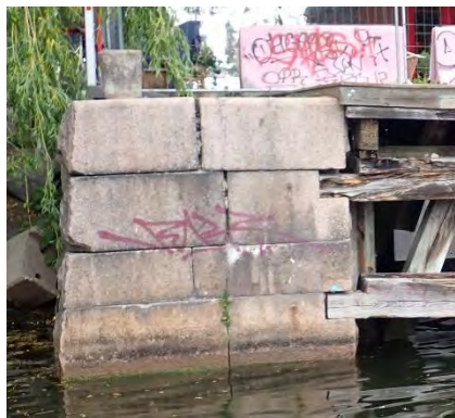
Foto 2 & 3 visar överbyggnadens på stenkista 1 utåt vattnets samt den välfogade inre sidomuren.
