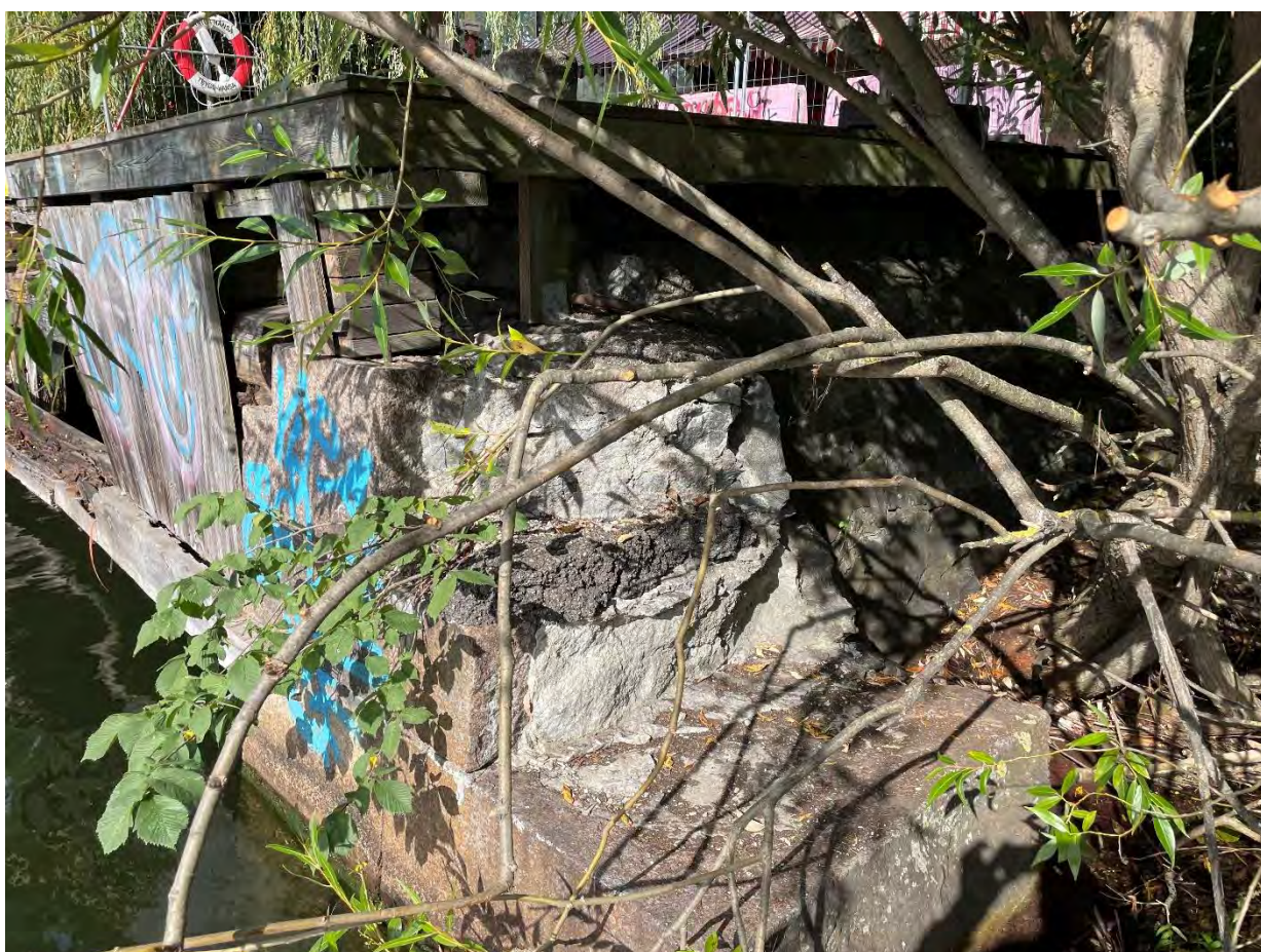
Bild 6: Södra upplaget för trädäcket.
