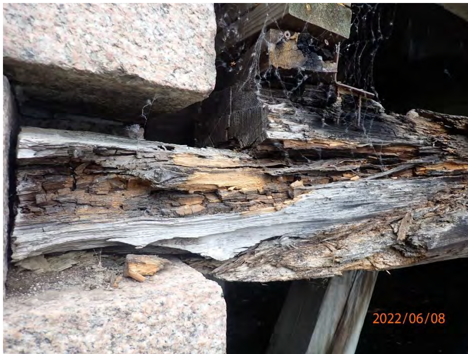
Foto 10 – visar detalj av upplag på den yttre balkkonstruktionen.
