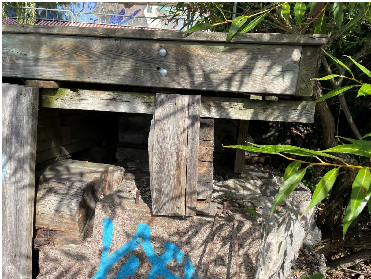
Bild 5: Södra upplaget för trädäcket.
