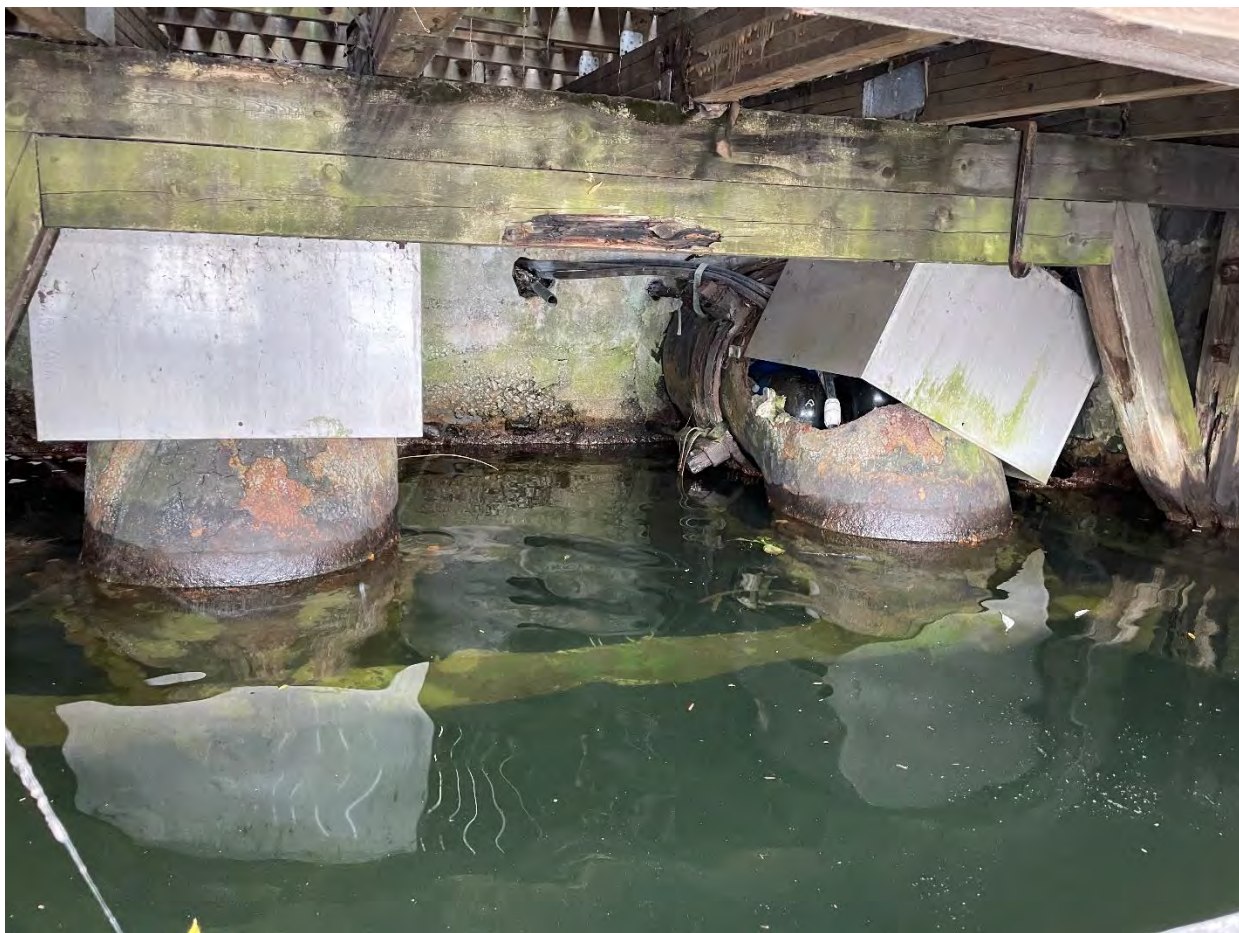
Bild 3: Ledningsdragnig under bryggan.
