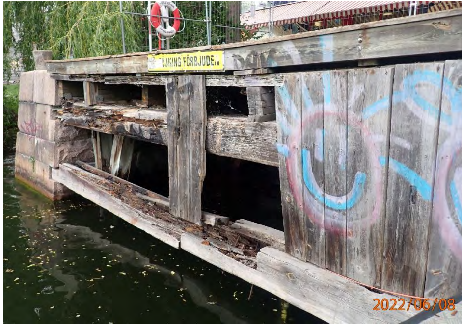
Foto 9 – visar den yttre bärande träkonstruktionen 2022
