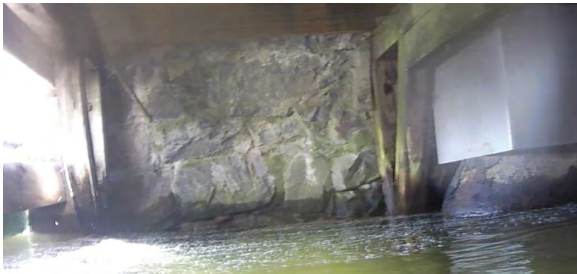
Foto 2 & 3 visar överbyggnadens på stenkista 1 utåt vattnets samt den välfogade inre sidomuren.
