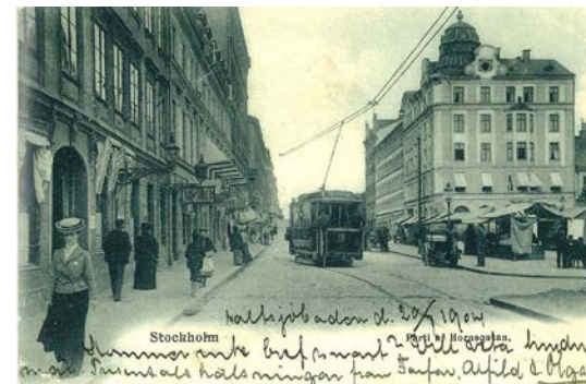
1902, Norra entén mot Hornsgatan.
