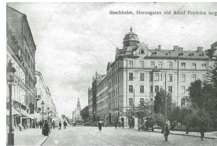
Vy åt Öster mot Slussen. Philipénska huset står färdigt sedan 1911. Parken har utvidgats fram till Hornsgatan, torghandeln har upphört. Vykortsboken av Peter Pluntky.
