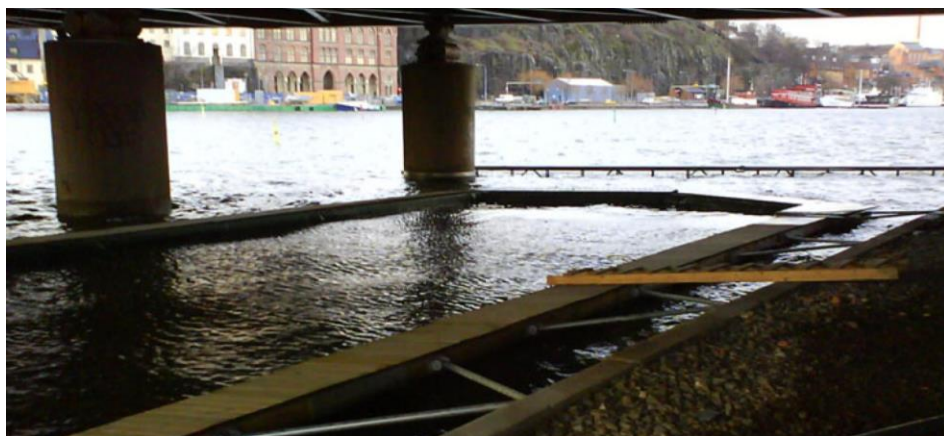
Skärmbassäng som tidigare fanns under Centralbron/Söderström. Foto från utredningsrapport om anläggningens funktion 7 .
