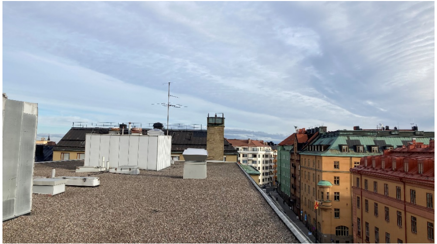
Del av befintligt tak som föreslås byggas på en våning (Stadsbyggnadskontoret).
