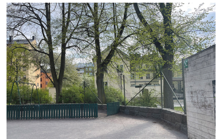
Foto visar stängsel ovanpå muren som föreslås tas bort.
