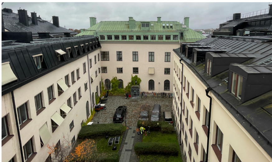
Innergården, fotat från Hus 2 mot öster (Foto: Tyréns).
