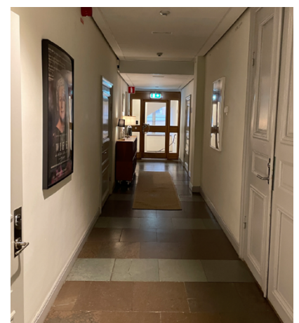
Korridor med öländsk kalksten inlagd på 1930-talet. (Foto: Tyréns)
