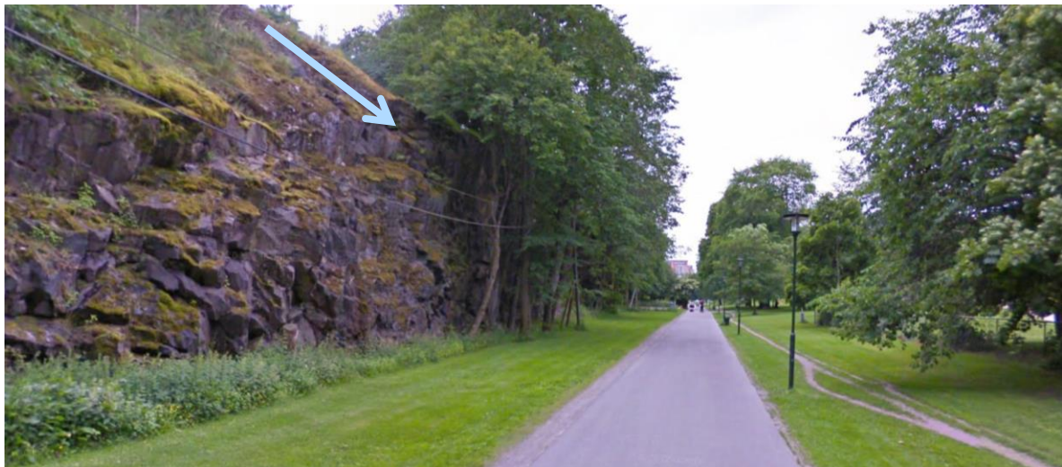
Figur 5-41. Befintlig situation Punkt 7 med bergssluttning, gräsremsa och gångbana.
