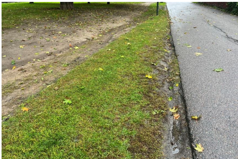
Figur 5-43. Skada i gräsyta från stående vatten samt erosionsskador.
