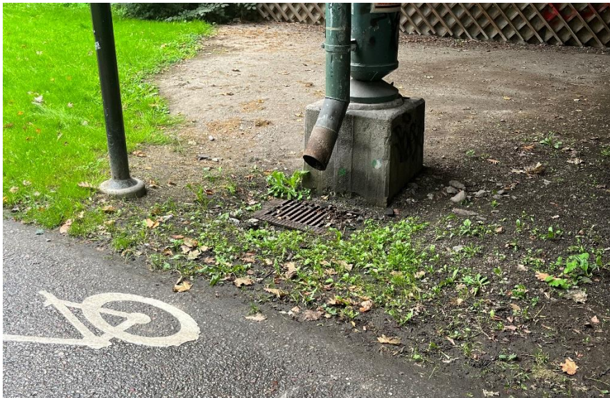
Figur 5-18. Befintlig dagvattenbrunn inom lågpunkten i Punkt 3.
