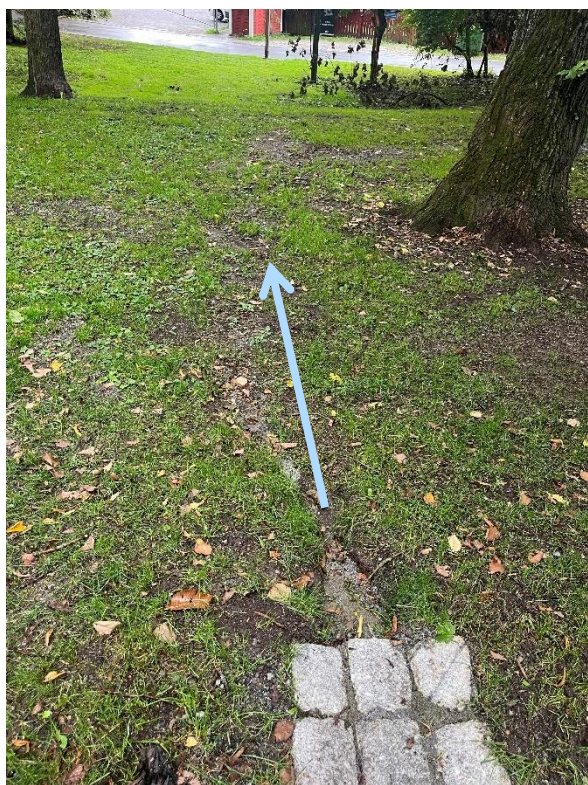
Figur 5-3. Befintlig rännadal som svänger in mot grönområde. Erosionsskador i befintlig gräsyta.
