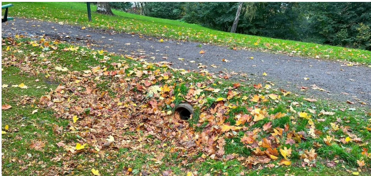
Figur 5-69. Trummans inlopp, foto från platsbesök.
