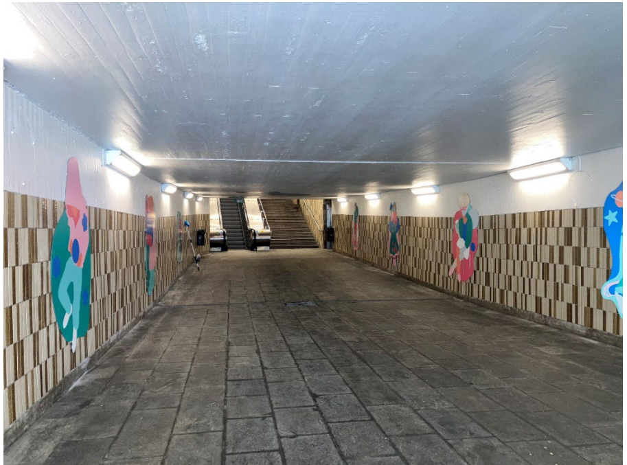
Bilden visar gångtunneln under Hornsgatan.
