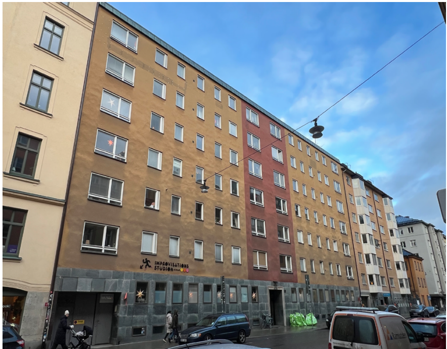
Flerbostadshusets fasad mot Skånegatan (Reichmann Antikvarier AB).
