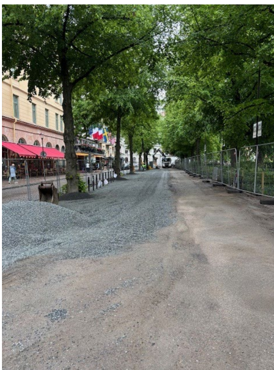
Utläggning av genomsläppligt markmaterial. Foto: Södermalms stadsdelsförvaltning.
