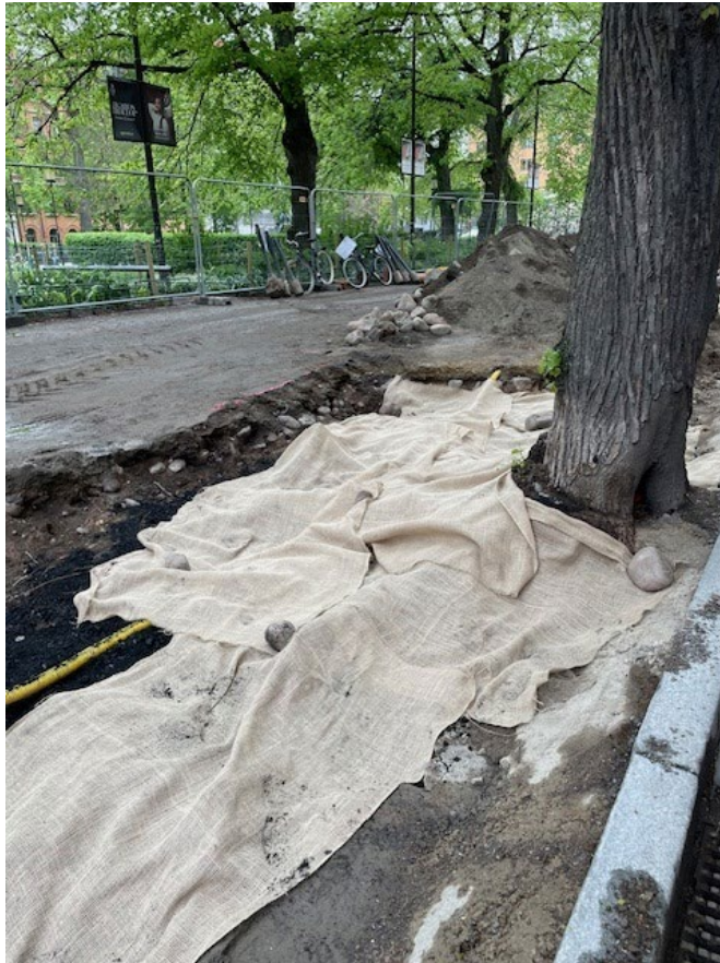
Växtbäddsrenovering med bicol.
