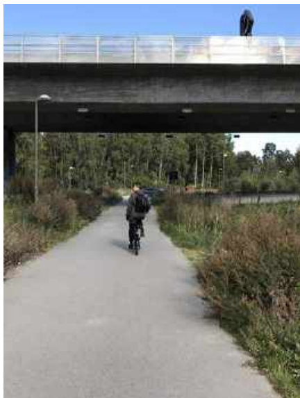
Cykelväg ut mot Järvafältet under järnvägsbron. Så råket kan framhävas tydligare.
