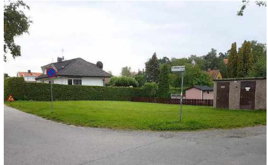
Öppen gräsyta med transformatorstation.
