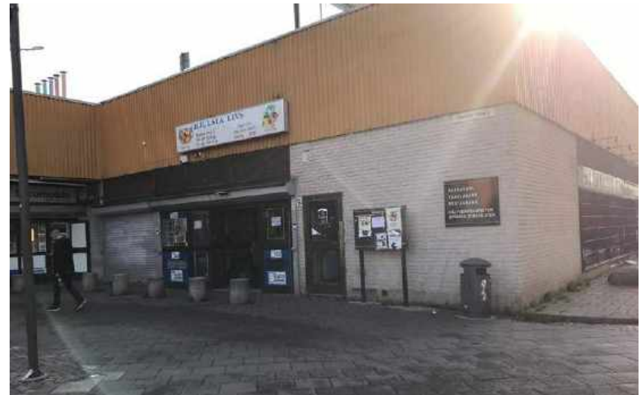
Torget ramas in av byggnadens fasad.
