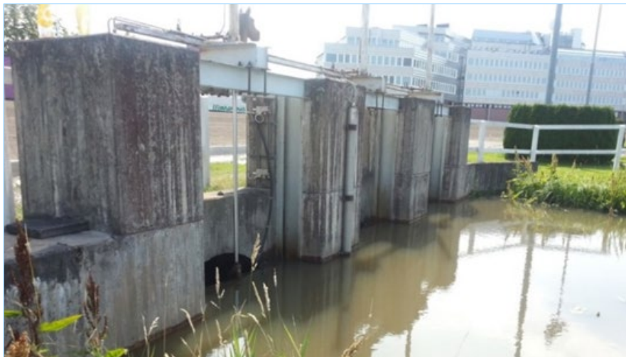
Solvalla travbana. Överfallsluckor inne på travbanan dämmer upp vattnet under tävlingarna. Foto: Tobias Fränstam
