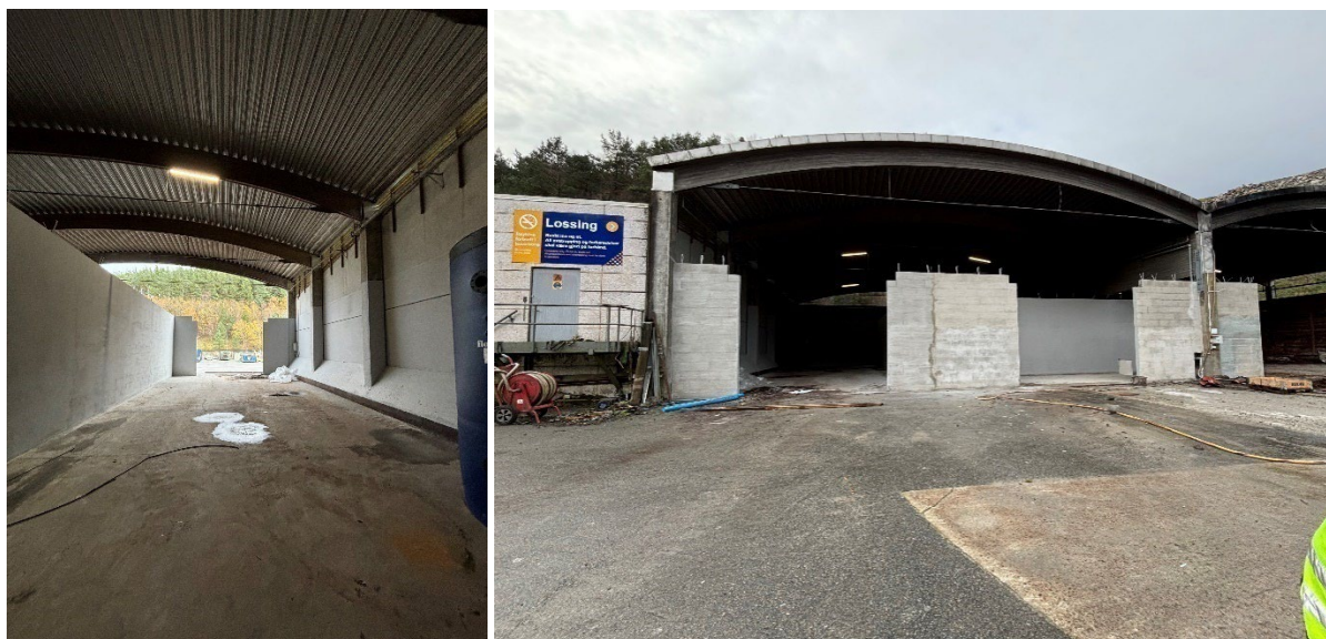
FIGUR 15 FÖRBEREDDA YTOR FÖR DEN NYA BIKOLPANNAN BioMaCon C400-F SOM BERÄKNAS VARA I DRIFT UNDER BÖRJAN AV 2025 (SANDNES, 2024).
