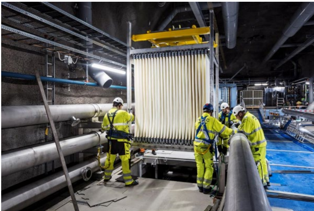
Figur 5 Montage av MBR-kassetter
