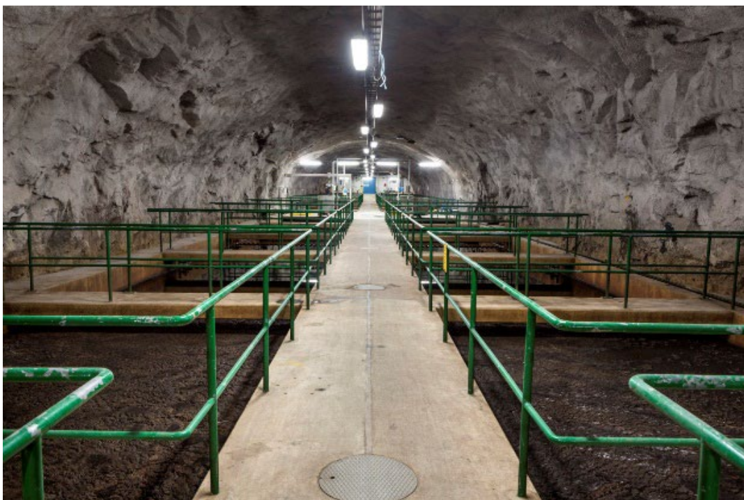
Figur 3 Eftersedimenteringsbassäng innan ombyggnad
