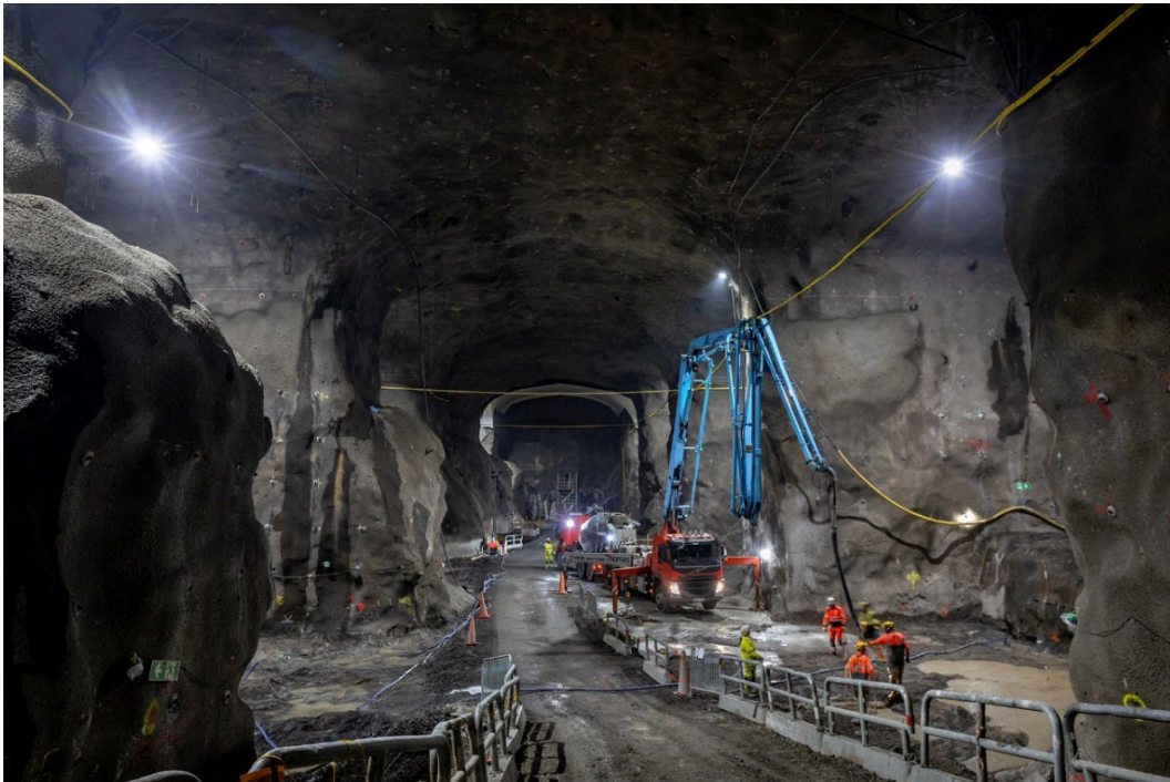
Figur 7 Arbeten inne i Sickla.
