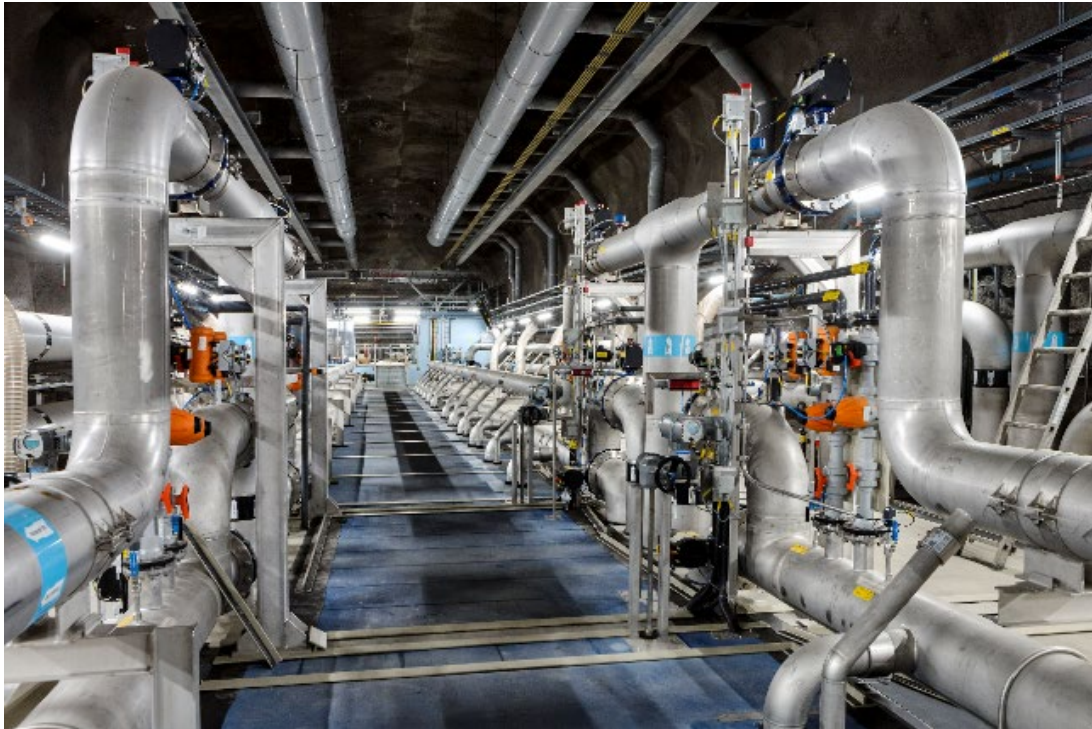
Figur 4 samma bassäng efter ombyggnad till MBR teknik, taket höjt och installationer på plats av 72 kassetter i varje bassäng
