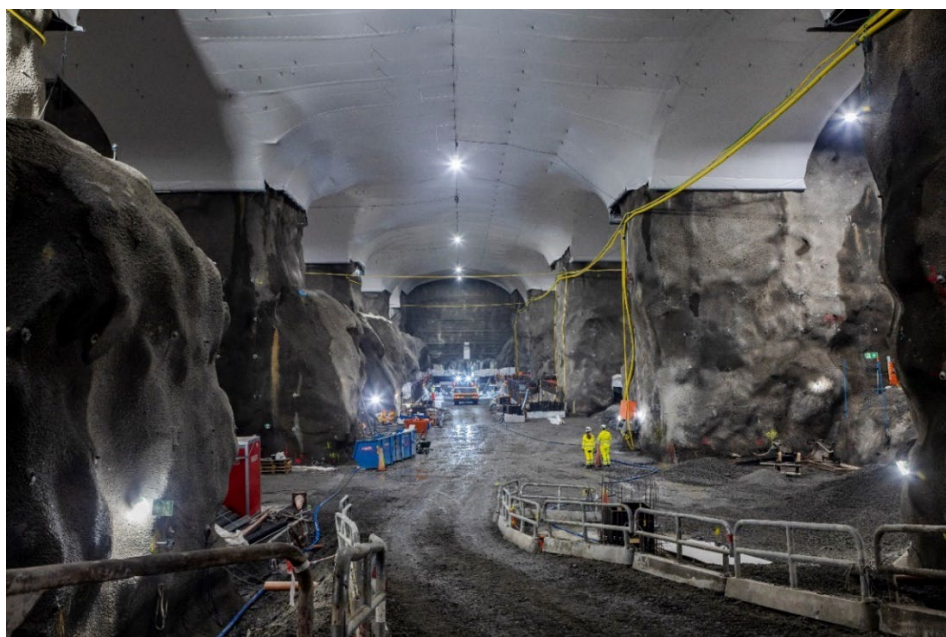
Armering och betongarbeten till försedimentering i Sicklaanläggningen
