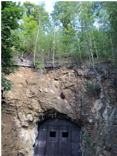
Tunnelöppning innan renovering.
