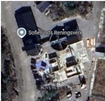
Flygfoto över Sofielunds Reningsverk som byggs ut.
