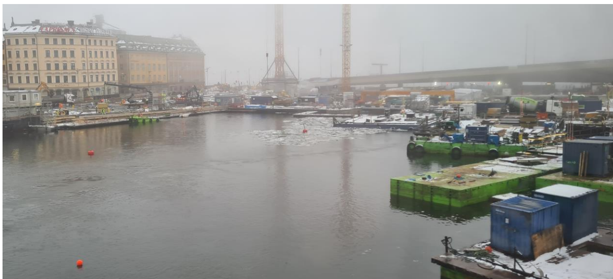
Byggnationen av nya Slussen i februari 2024. Foto: Joakim Lücke.
