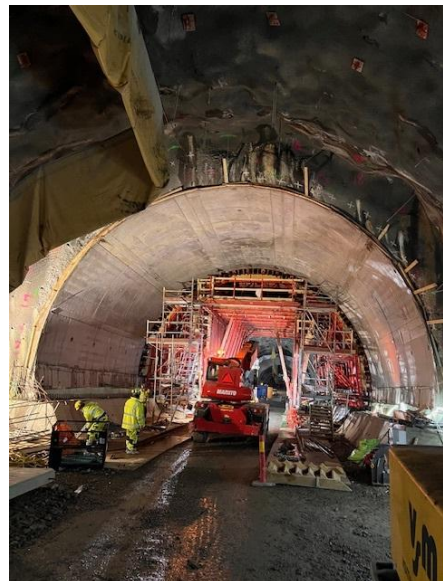
Figur 2. MP01 svaghetszon, gjutning av avjämningsbetong
