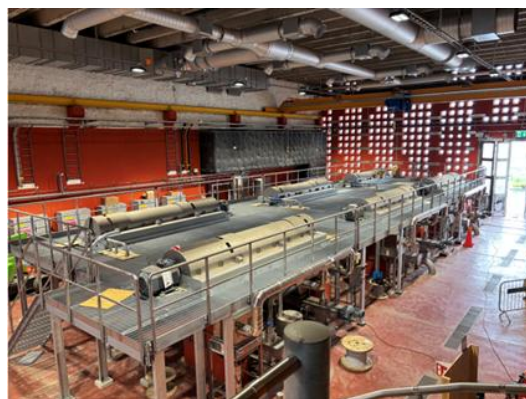
Figur 4. Slambyggnaden 2026–05. Stora centrifughallen.
