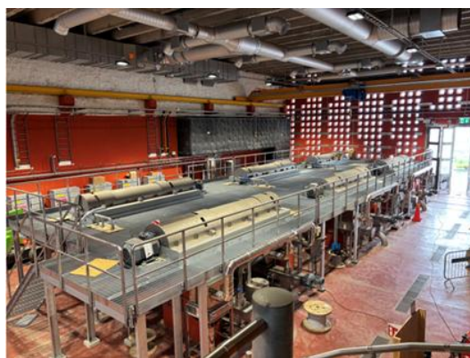
Figur 4. Slambyggnaden 2026–05. Stora centrifughallen.
