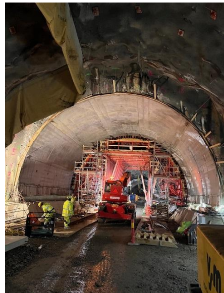
Figur 5. MP01 svaghetszon, gjutning av avjämningsbetong
