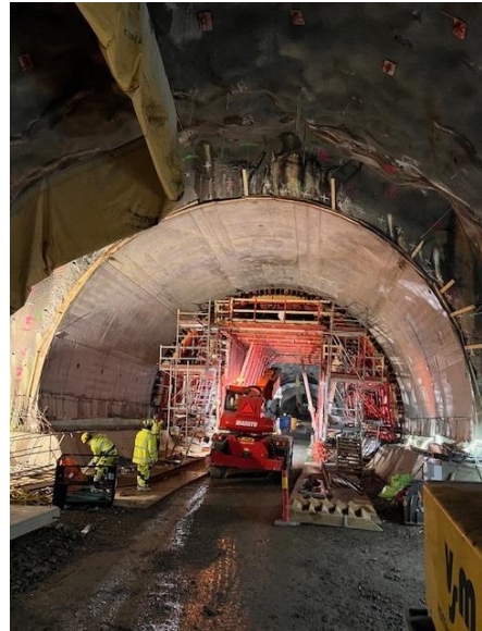
Figur 6. MP01 svaghetszon, gjutning av avjämningsbetong
