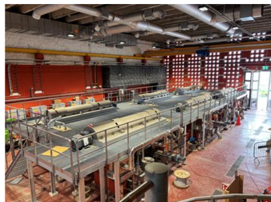
Figur 4. Slambyggnaden 2026–05. Stora centrifughallen.
