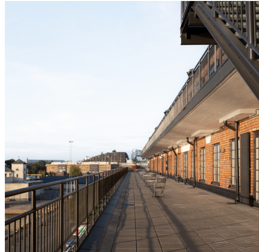
Färdigställd fasad och terrass
