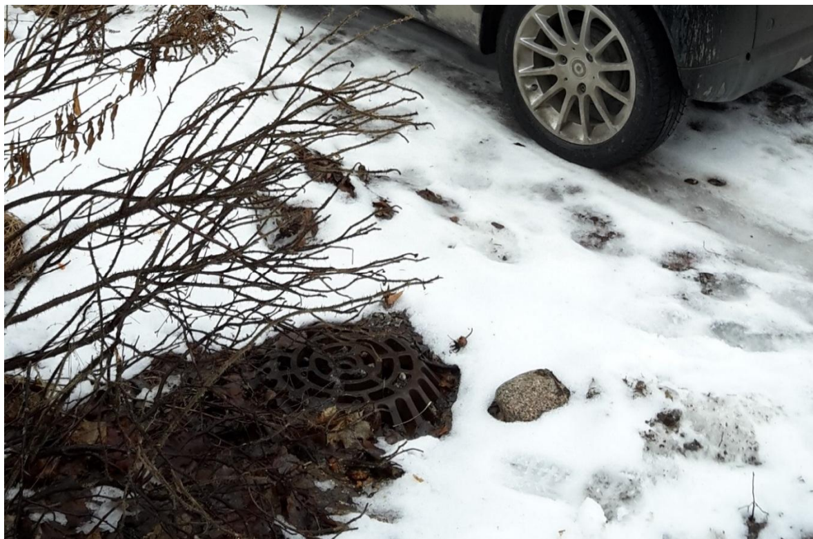
Bilaga fig 3. Befintlig brunn i anslutning till parkeringens infart. En likadan finns enligt ritningar på andra sidan infarten men där låg en snöhög vid tidpunkten för platsbesöket.
