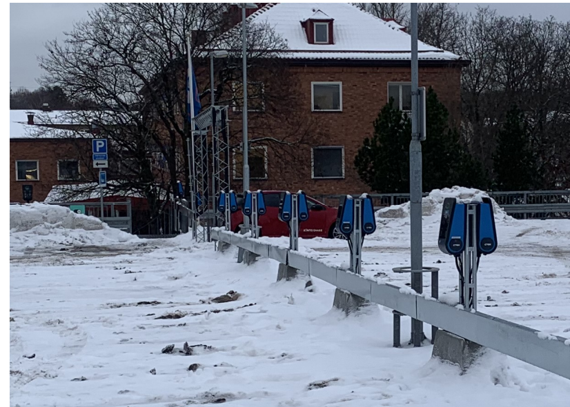
Portal monterades vid korsande körbana
