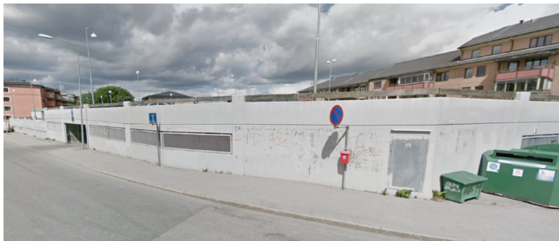
Befintligt parkeringsdäck som rivs för att möjliggöra projektet
