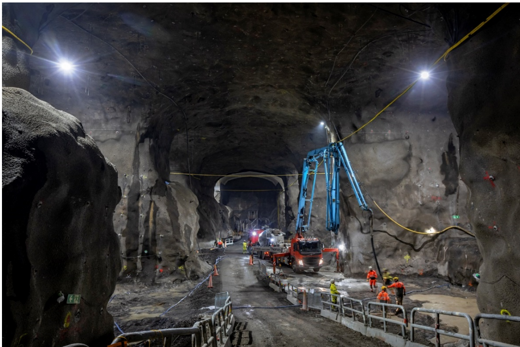
Figur 7 Arbeten inne i Sickla.
