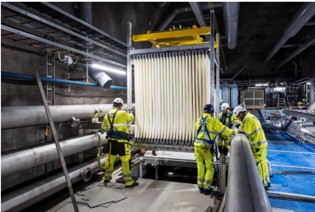
Figur 5 Montage av MBR-kassetter
