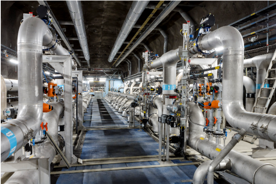
Figur 4 samma bassäng efter ombyggnad till MBR teknik, taket höjt och installationer på plats av 72 kassetter i varje bassäng
