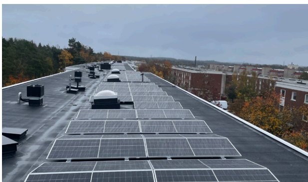
På Byälvsvägen i Bagarmossen anlägger vi vår – och Stockholms – största solcellsanläggning. Totalt handlar det om 5 500 m 2 solceller på 28 tak. Foto: Stockholms hem
