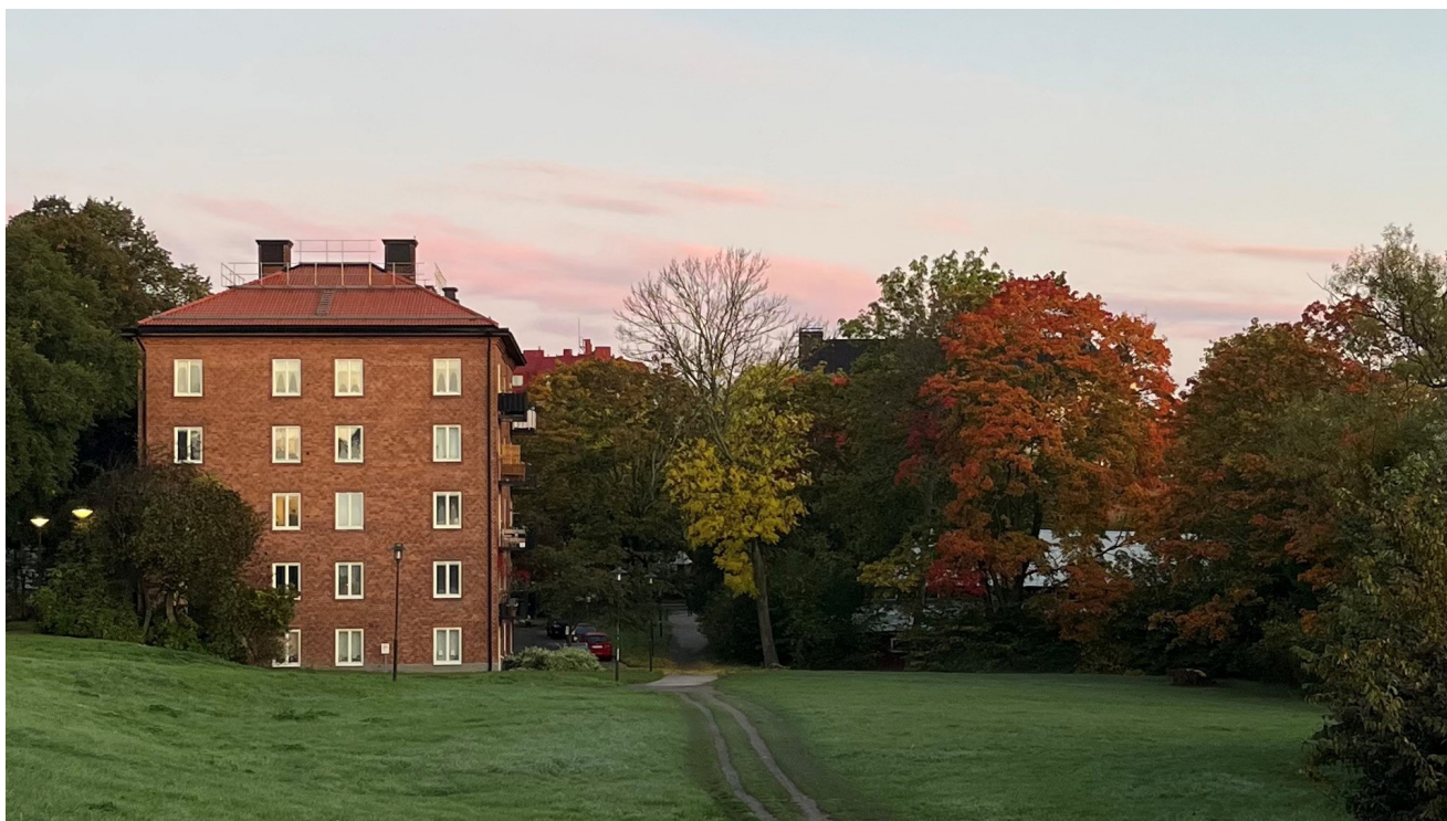
Föregående sida: Barn från en förskola i Rågsved på invigningen av muralkonstverket som de själva varit med och skapat. Ovan: Stockholmsshems fastighet Fören 2 i Gröndal.
