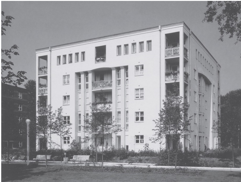
Bild på Rauchstrasse i Berlin "stadsvillor"
