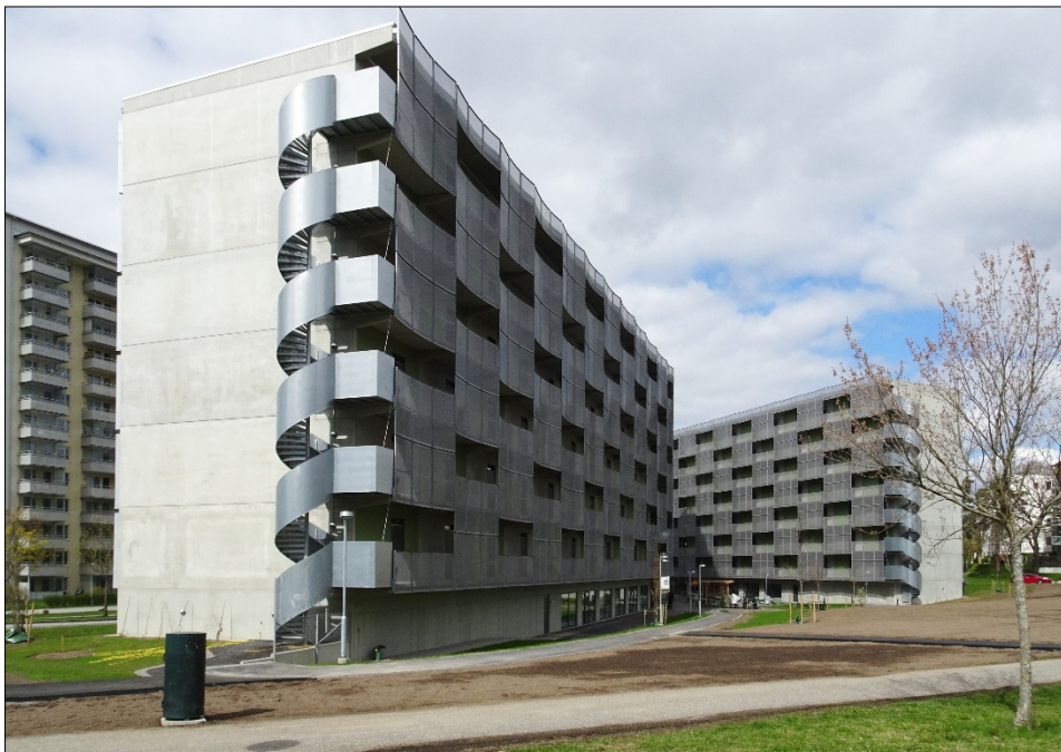
Bild 1: Hus C mot Hus B, sett från gångvägen över fältet.
