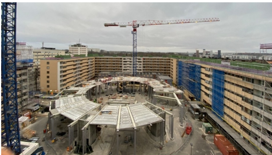
Bild 1. Bild över gårdshuset där uppförandet av stommen är påbörjad.
