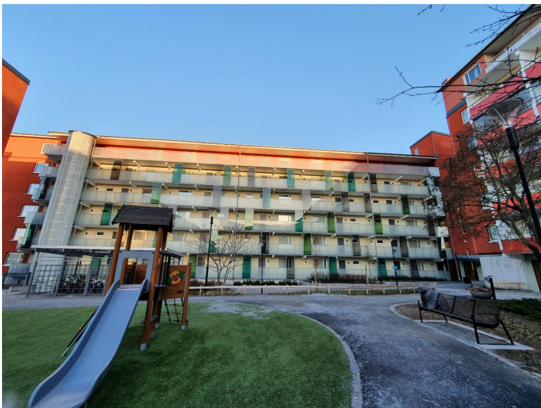
Bild 1. Oslogatan 22 med återuppbyggd påbyggnad efter brand.
