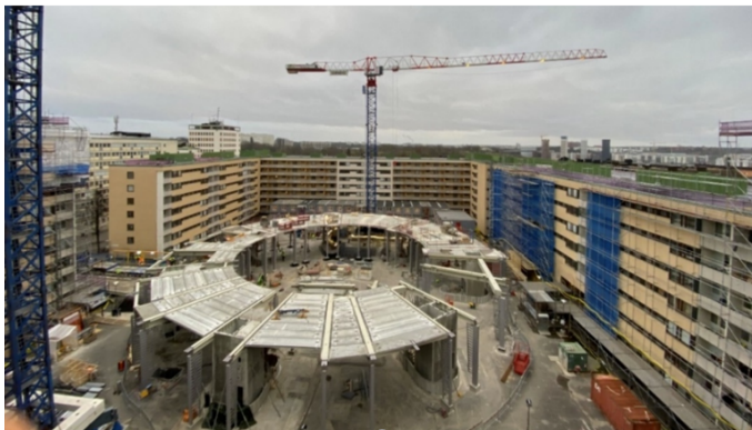
Bild 2, påbörjad stomme vid tiden för hävning
