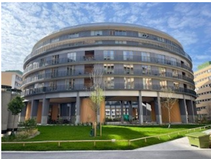
Bild 1, vy över det nybyggda huset på gården
