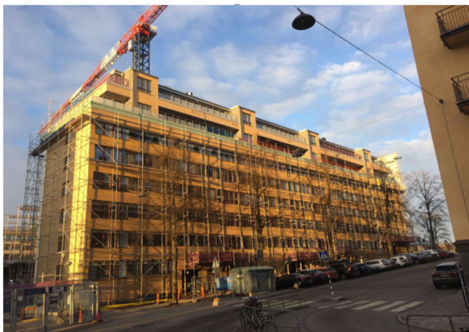
Bild 3, påbyggnad av de 25 lägenheterna under produktionen
