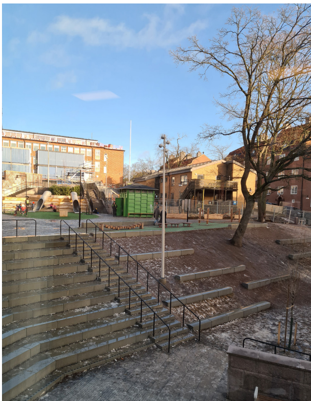
Befintlig utemiljö med gradäng
