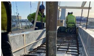
Koldioxidreducerad betong vid bygge i Värtahamnen
