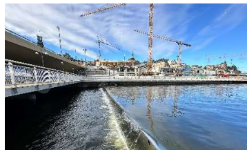
Avtappning i Slussen
