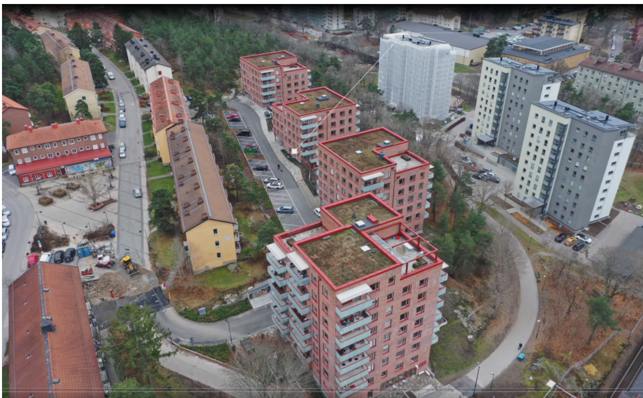
Bild från drönare på de färdigställda husen.
