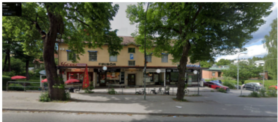
Bild 2a – befintlig byggnad. Källa: stadsbyggnadskontoret.
