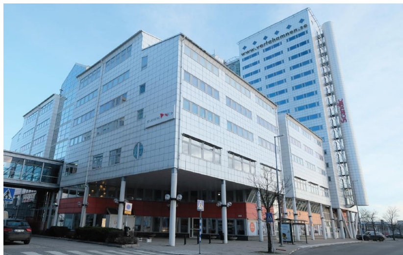
Befintlig byggnad, block 1 kvarter D2, Foto: Nyréns Arkitektkontor
