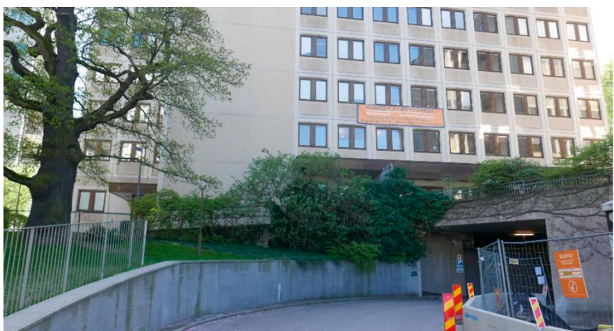
Vy norrifrån. Garageinfart under befintlig byggnad.
