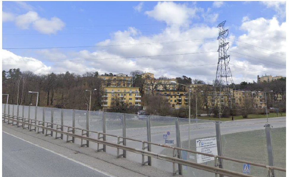
Stolpe nr 544 vid Bergiusvägen och bostadsområdet Ekhagen. Stolpen kommer ersättas av två kabeländstolpar närmare Norrtäljevägen. Foto Google Maps.
