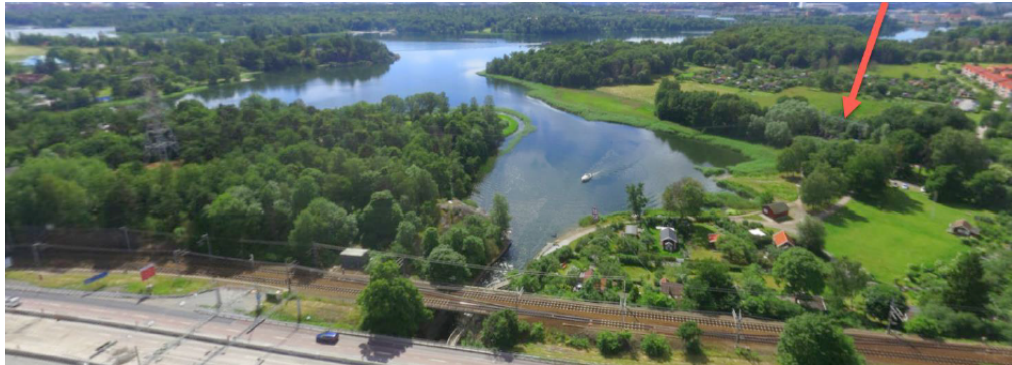
Befintlig luftledning vid passagen över Ålkistan. Till vänster i bilden syns stolpe nr 542. Pilen markerar terminalplatsen vid Ålkistan. Norrtäljevägen och Roslagsbanan syns i förgrunden. Drönarbild från ©2019 FastOut AB.
