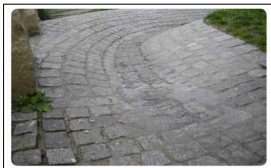
Figur 9-3. Ränna (Uppsala Vatten, 2016)
